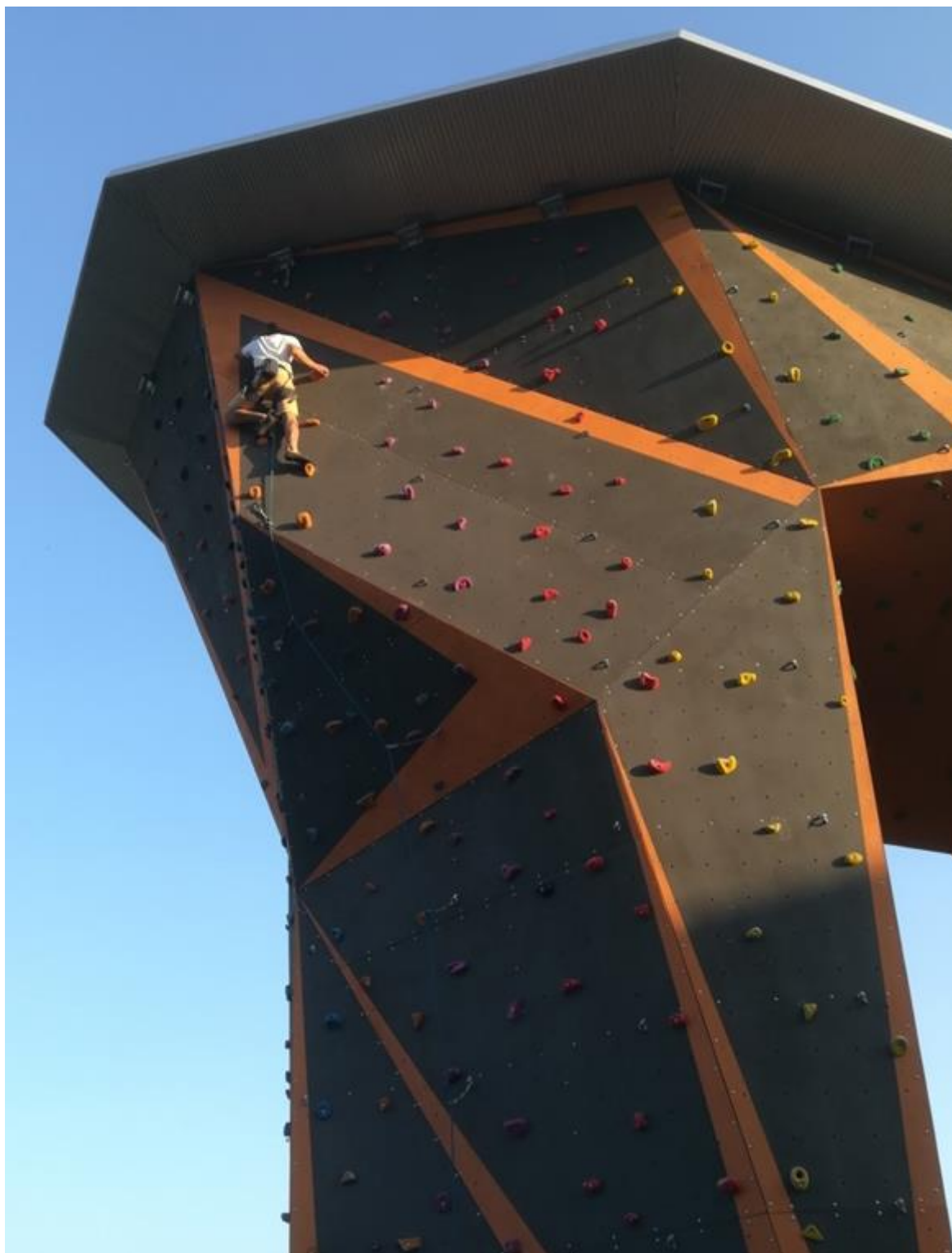
Parede de Escalada da Rodovia de Braga
